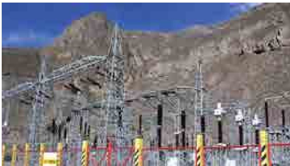
Central Hidroeléctrica - Charcani V
